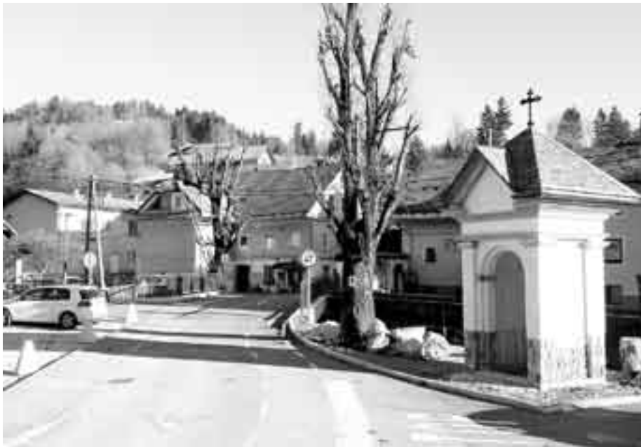
Dela na mostu pri Vidmu so bila opravljena v sedmih tednih.
