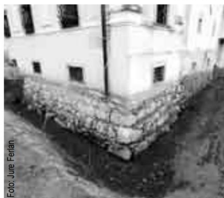
Različni gradbeni fazi sta lepo vidni tudi v temeljih dvorca.
